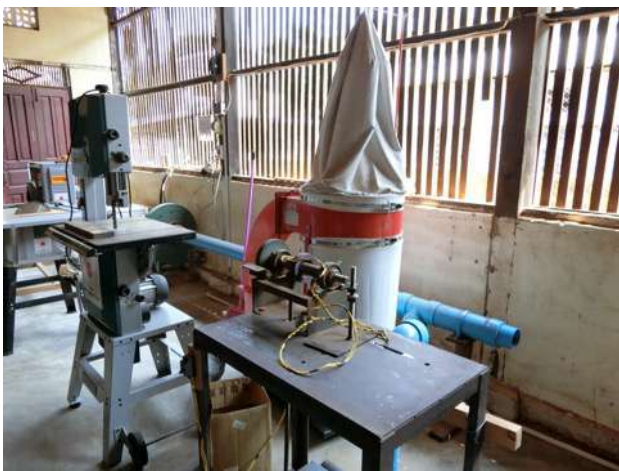
労働衛生環境改善のための集塵システム（写真奥）
